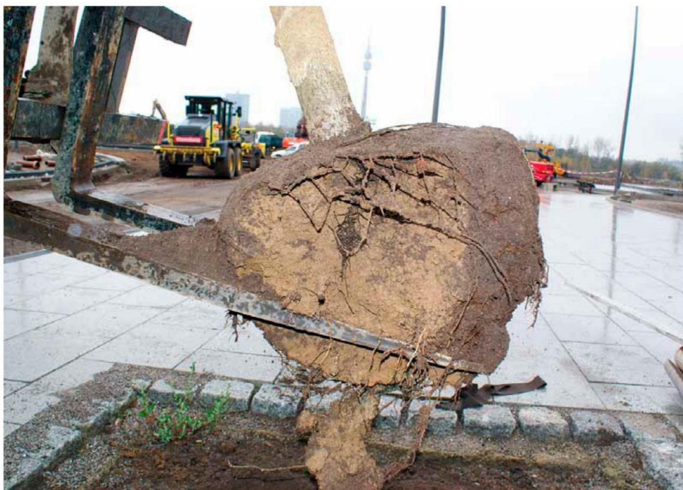
So etwas gehört nicht in den Boden. Mit dem Dreibock hält so ein im Ballenbereich beschädigter Baum leider selbst ohne Wurzeln. | Alle Fotos: L. Wessolly
